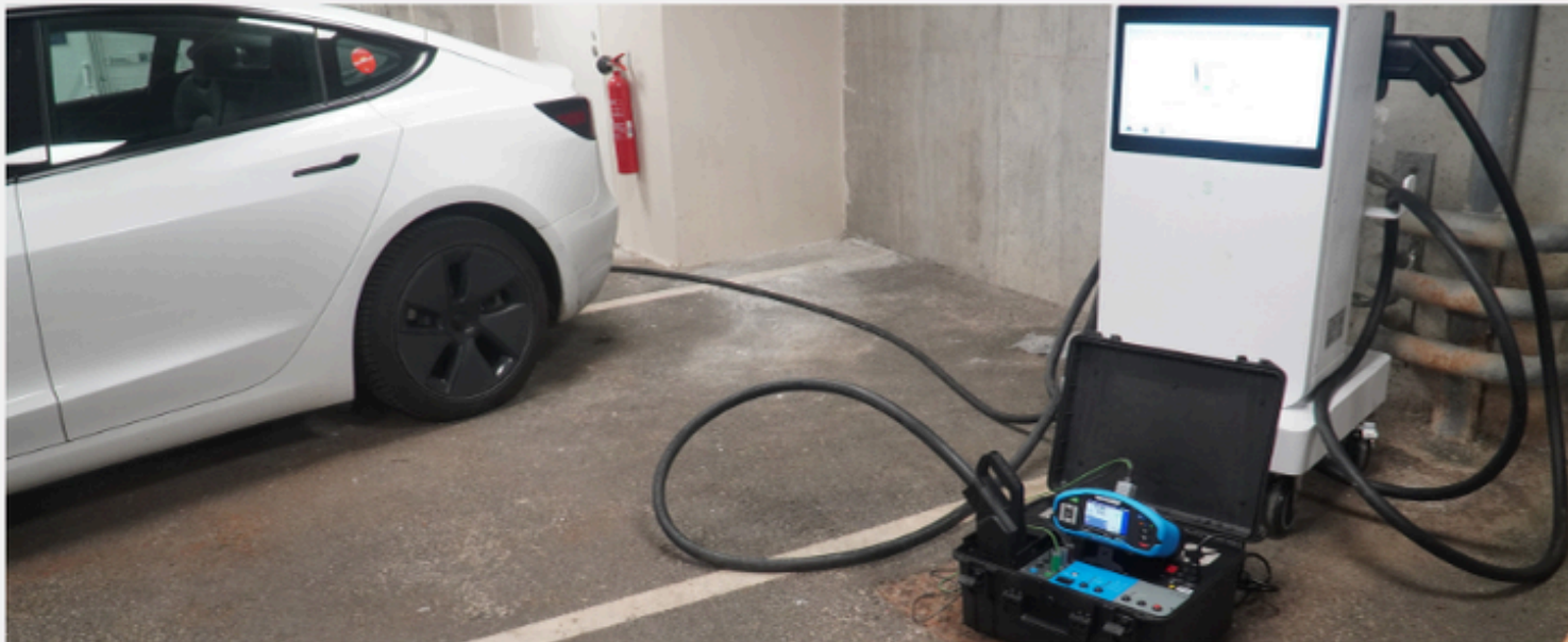
Le A1732 et le MI3155ST en application pour le test d'une borne DC
